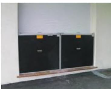
Il n'est pas conseillé d'utiliser ce système pour des hauteurs d'eau supérieures à 90 cm (la structure des murs n'est généralement pas prévue pour soutenir de telles pressions). D'autre part, dans le cas d'une inondation longue (> 48h), les infiltrations (par le sol et dans les murs) finissent par réduire son efficacité.
