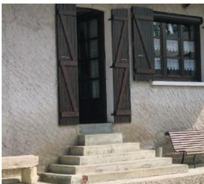
La réhausse d'un plancher peut être intéressante dans quelques cas précis : la hauteur d'eau est faible, ou la hauteur de plafond disponible est importante ou peut être augmentée (suppression des combles). Dans ces cas, le plancher des parties inondables peut être rehaussé. Il devra être accompagné par le déplacement des cloisons.
