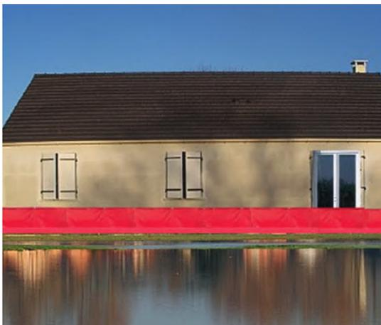
Il s'agit d'une bâche étanche, fixée par des crochets sur la façade.
