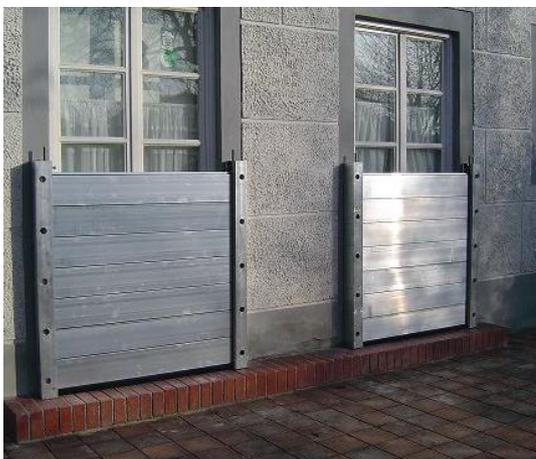
Il s'agit d'une variante de batardeaux qui peut être posée le long des fenêtres ou sur les soupiraux et les trappes d'aération en compléments des ouvertures de portes.
