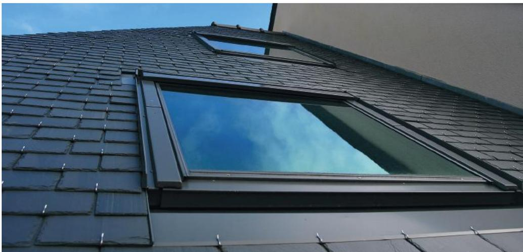
La pose d'une fenêtre de toit permet d'envisager l'évacuation du logement et diminue les risques de noyade. Elle peut également être installée lors de la construction d'une zone refuge.
