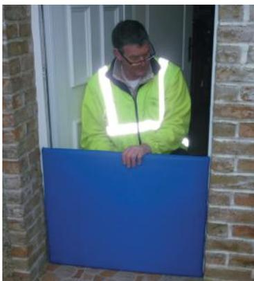
Il s'agit d'occulter les ouvertures (type portes, portes-fenêtres et portails) afin d'empêcher l'entrée de l'eau dans le bâti. Plusieurs systèmes existent sur le marché, mais le principe de base est souvent le même : une structure verticale qui reprend la poussée de l'eau (soit en coque, soit en poutres empilables) est glissée et s'appuie dans un système de rails fixés au chambranle de l'ouverture.
